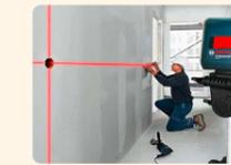
壁開口箇所墨出し (施工図に合わせて床や壁に印つけを行う作業)
