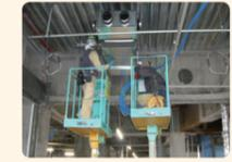
機器吊り込み (エアコンを吊る作業)
